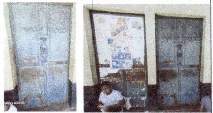
Foto 2: PUERTAS DE METAL: mantenimiento a estructura (lijado, cambio de tubo, cepillado, sujeciones) y sustitución de chapa, 13 puertas
