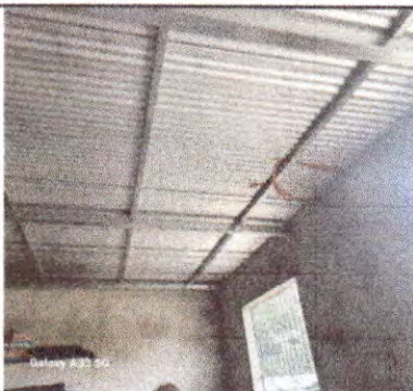
Foto 11: instalación unidades de luz
