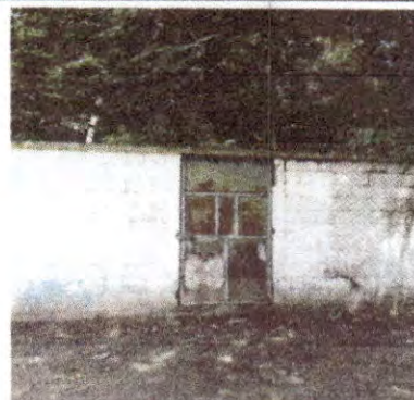
Foto 10: Fabricación e instalación de puertas
