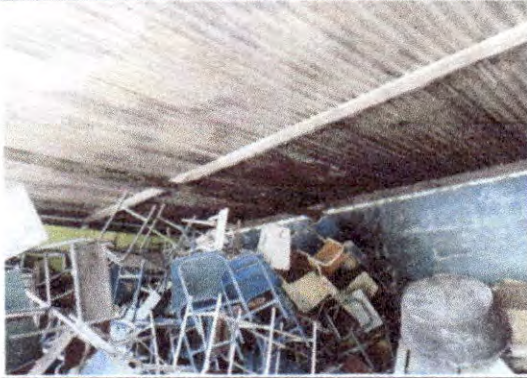
Foto1: Sustitución de lámina, Estructura de metal.
